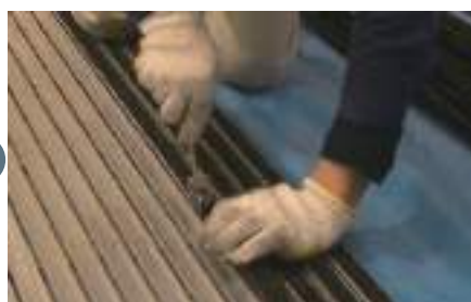
⑤ 新しい上部マットを取り付けていきます。
