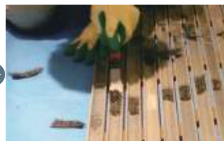
③ ヘラを使用して接着により残っていた部分を取り除きます。
