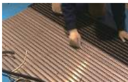
④ アルミベースを綺麗にした後に接着剤を塗布します。
